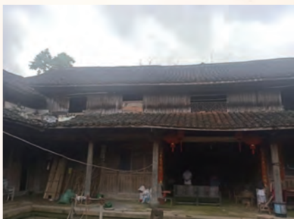
华阳小筑庭院内
